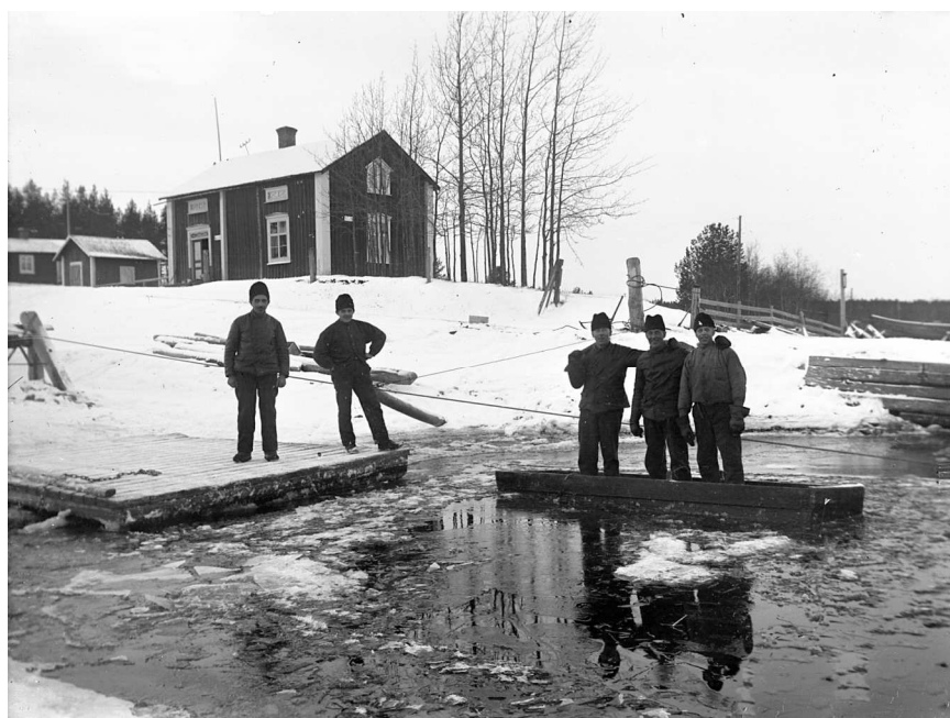
Utläggning av pontonbro, bröderna Åman, ca 1930
